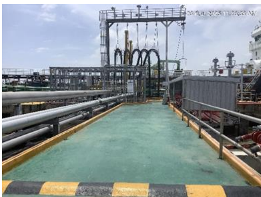
ภาพที่ 2-7 คันคอนกรีตสูง 0.10 เมตร บริเวณหน้าท่า
