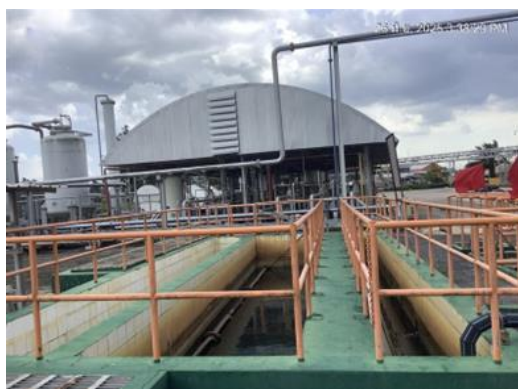
ภาพที่ 2-3 บ่อดักตะกอน (Collection pond)
