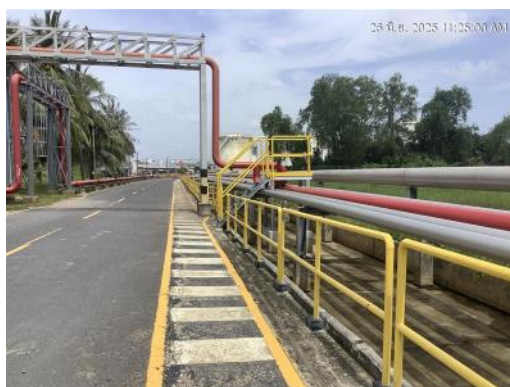
ภาพที่ 2-2 รางระบายน้ำคอนกรีตภายในคลัง
