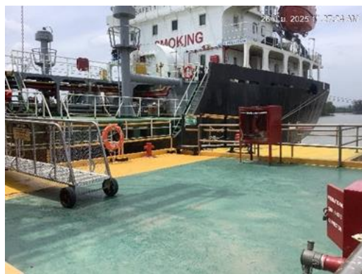
ภาพที่ 2-7 คันคอนกรีตสูง 0.10 เมตร บริเวณหน้าท่า
